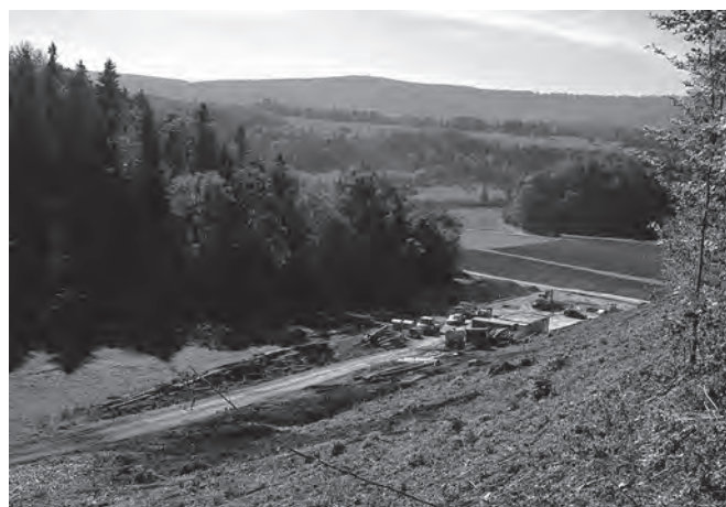
Fig. 36 Vue de Combe Ronde, située à la bordure sud du Plateau de Bure. L'emplacement des conteneurs et des engins de chantier correspond au domaine morphosédimentaire B (fig. 21). Au deuxième plan, la vallée sèche principale de la Haute-Ajoie (champs cultivés) au niveau de Lai Coiratte et un peu plus loin le début de la vallée sèche de Combe En Vaillard ainsi que l'anticlinal du Banné (fig. 3). A l'horizon se déploient les reliefs de la chaîne du Jura plissé.
